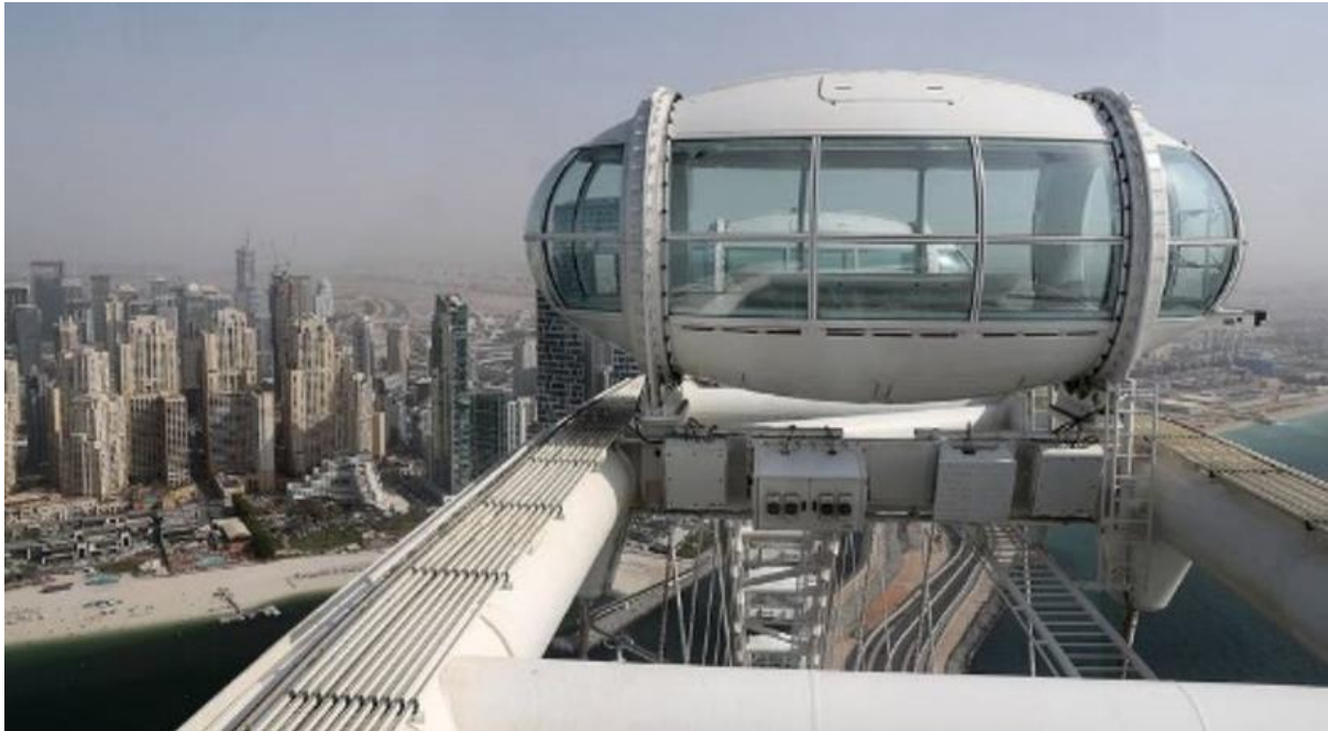
Figura 2 Sotto la cabina sono visibili le unità contenenti le apparecchiature elettroniche ( https://whatson.ae/2021/08/sneak-peek-take-a-look-inside-ain-dubais-premium-cabins/ )
