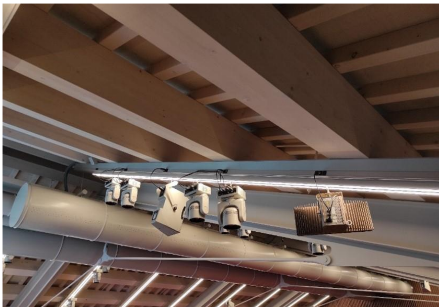
Figura 5 I binari multimediali contengono le led-strip per l’illuminazione generale della sala e supportano i diversi apparati scenotecnici e audiovisivi
