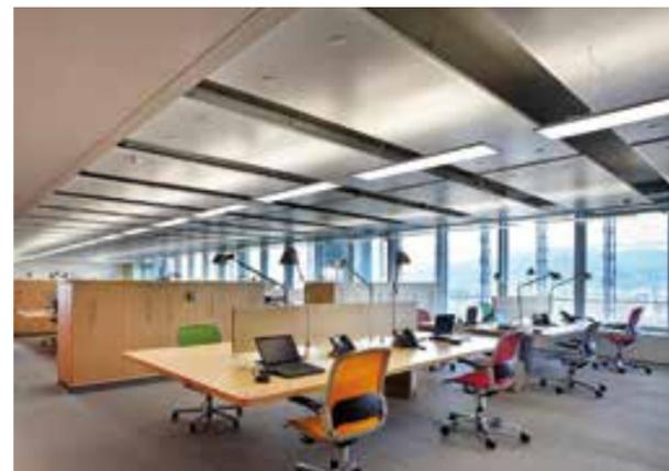
Vista interna degli uffici con pannelli radianti a soffitto e lampade sospese per illuminazione diretta e indiretta.
