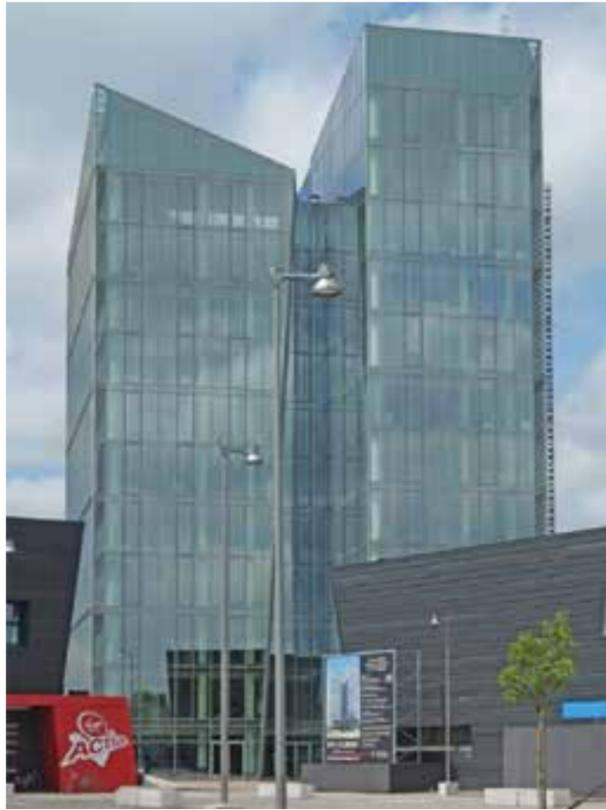
L'attuale tendenza architettonica verso superfici esterne interamente vetrate impone l'adozione di sistemi di facciata particolarmente efficienti dal punto di vista dell'isolamento termico ma richiede anche un attento studio dell'isolamento acustico sia tra l'interno e l'esterno (isolamento di facciata) che tra ambienti contigui, le cui pareti divisorie si attestano sui profili, talvolta esigui, della superficie vetrata.
