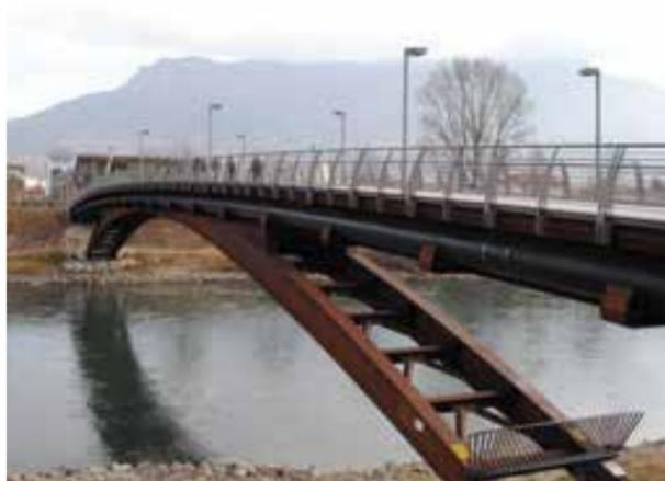
Attraversamento dell'Adige da parte dell'impianto di teleriscaldamento e teleraffreddamento, dalla centrale di trigenerazione al quartiere Le Albere.
