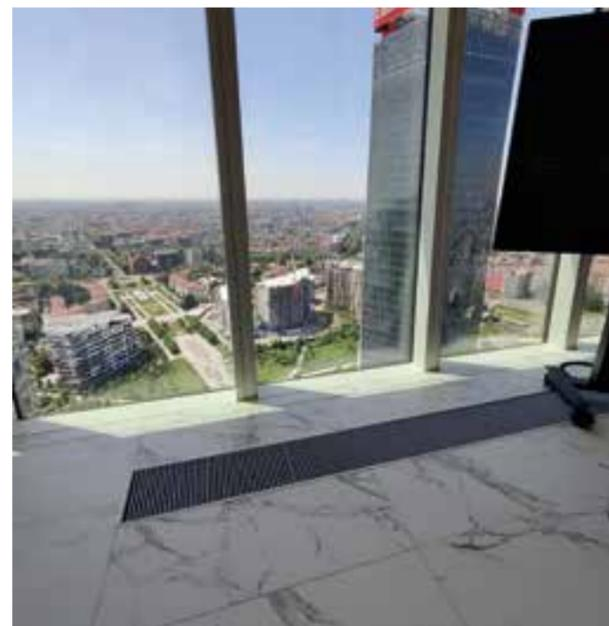
Dettaglio della facciata con ventilconvettori a incasso nel pavimento.
