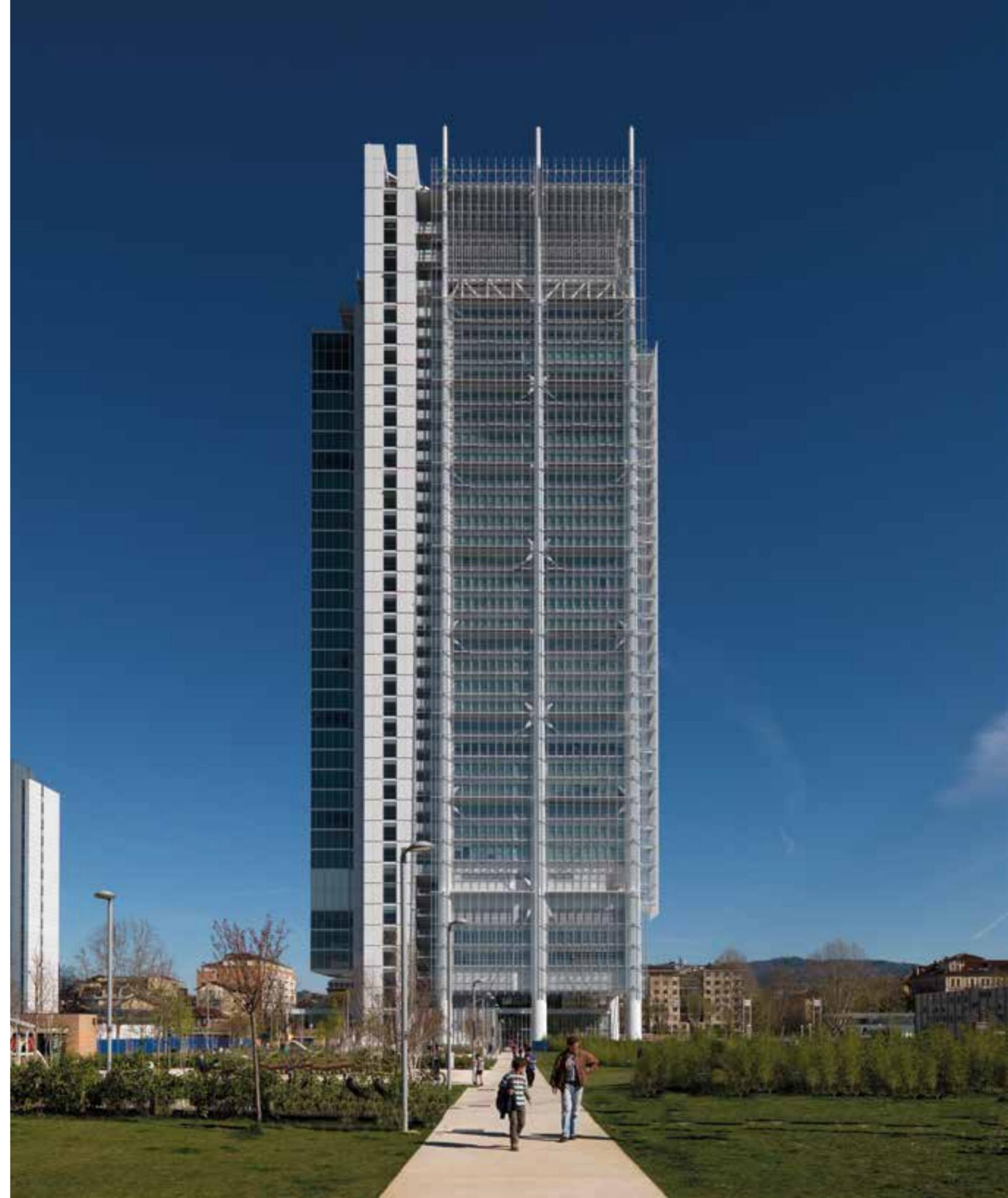
La torre è stata costruita secondo i più avanzati principi di sostenibilità ambientale, adottando più sistemi per l'efficienza energetica. Le facciate est ed ovest sono del tipo a doppia pelle; la facciata sud è quasi interamente ricoperta da pannelli fotovoltaici per circa 1600 m<sup>2</sup>; sullo stesso lato della facciata vi è un giardino d'inverno, che fa da contorno ad una scala "fredda" di connessione tra i piani.
